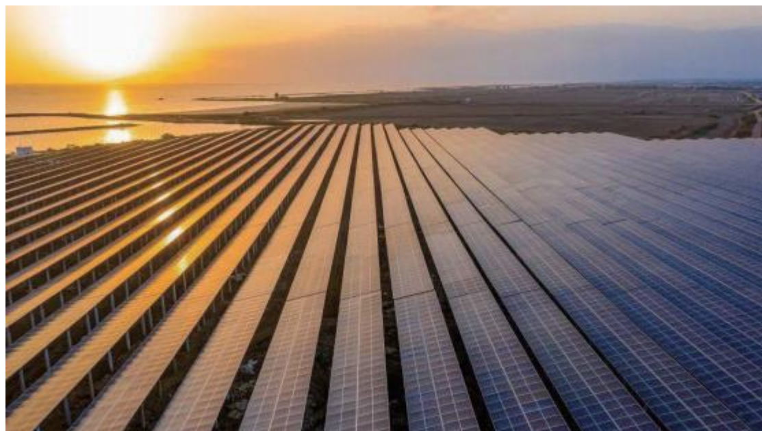
📍 台山海宴100MW近海项目
