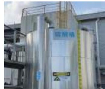
塩城テクノロジーは酸吸収用の硫酸投与装置を設置
