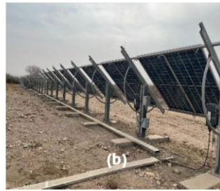
図 36.b. トリナ・ソーラー Vertex (210 mm) 両面受光型を使用した銀川太陽光発電所
